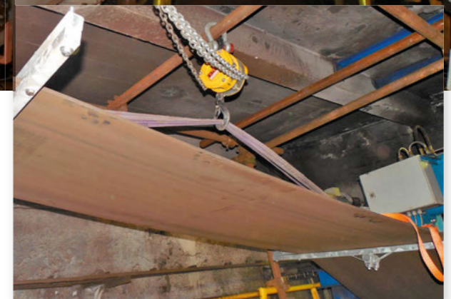
Nadzvednutí stávajícího pásu v prostoru instalace
