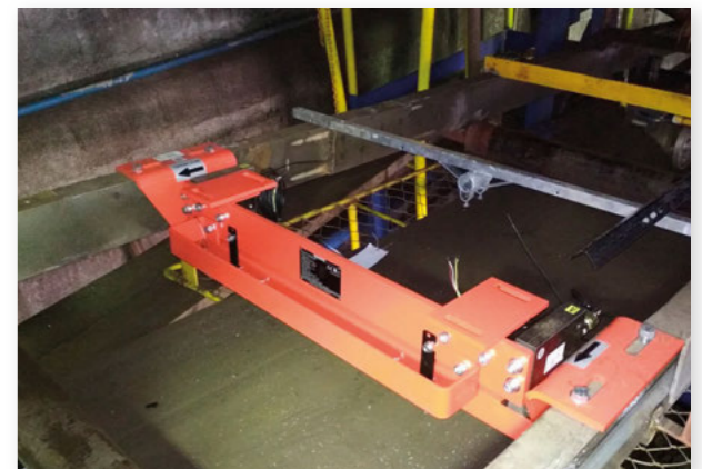
Montáž pásové váhy Milltronics MSI
