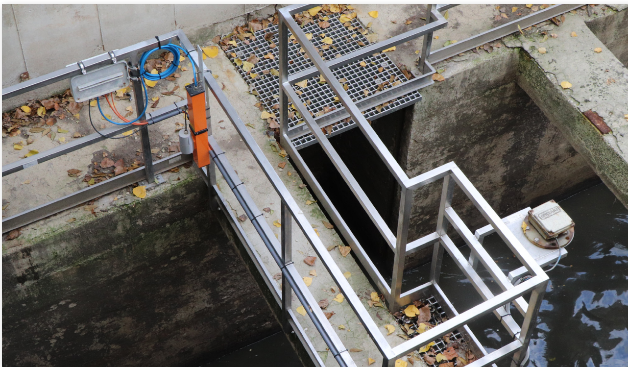
Systém nepřetržitého monitoringu úniku ropných látek pro čistírnu odpadních vod.
