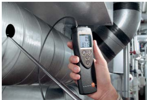
testo 425 při zjišťování objemového průtoku odsávaného vzduchu
