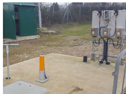
Kontrola vody u nádrže
